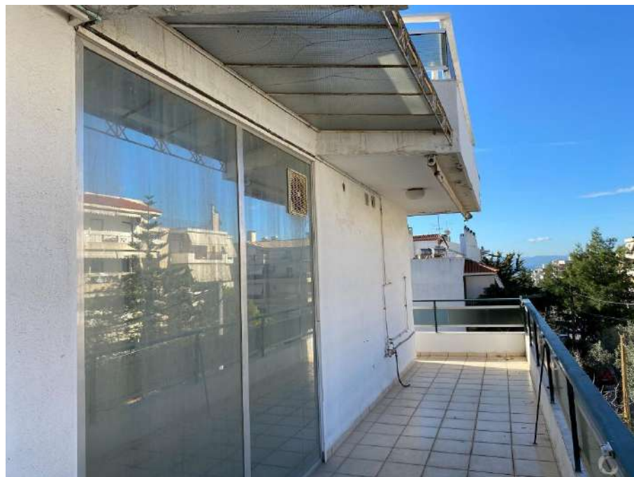
Εξωτερική άποψη εξώστη
