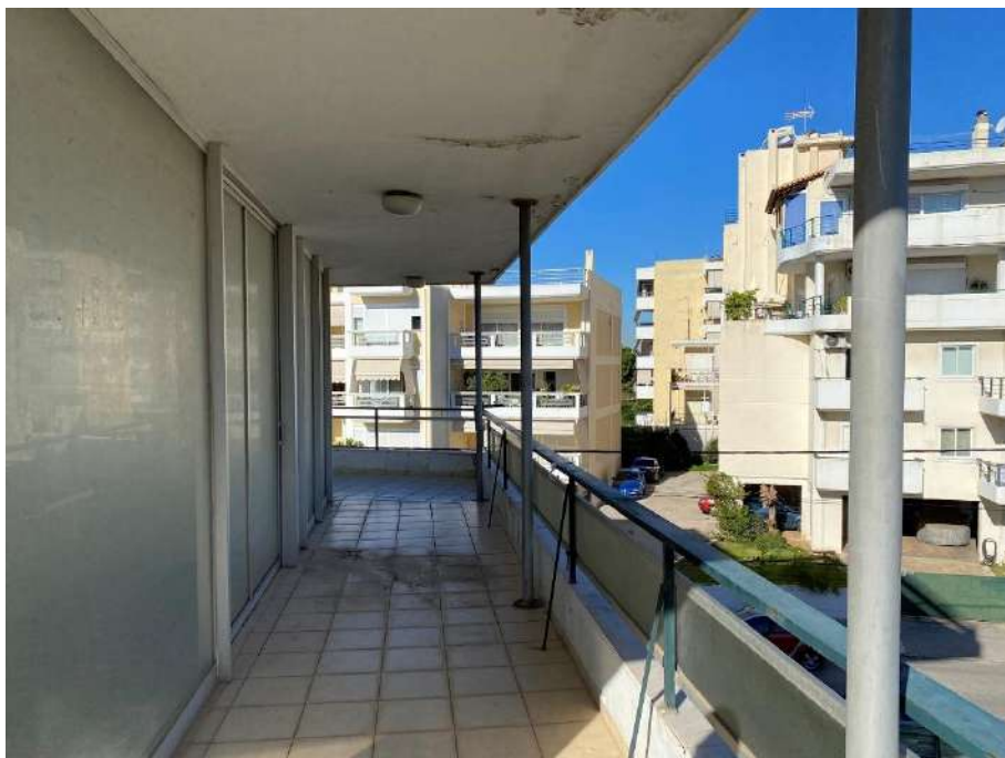
Εξωτερική άποψη εξώστη
